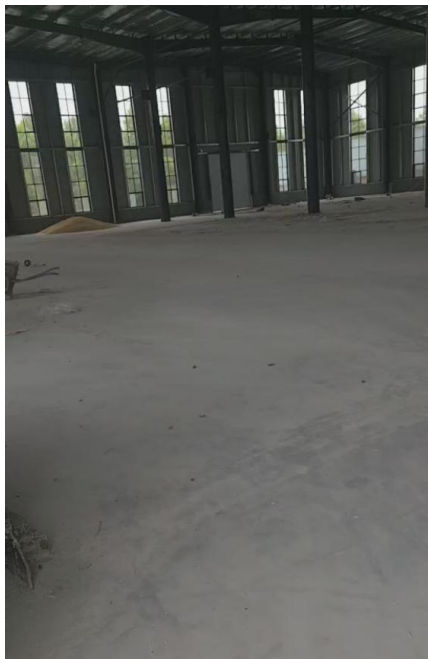
本项目车间现状
